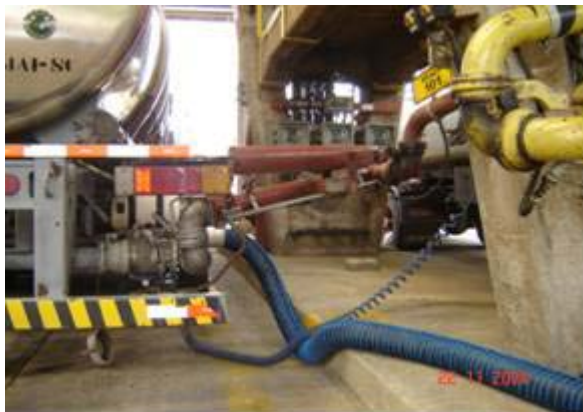
Sistema de cargamento de producto y colecta de los gases emitidos durante la carga
