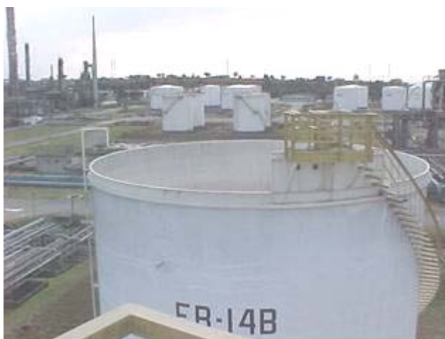
TANQUE CON TECHO FLOTANTE
