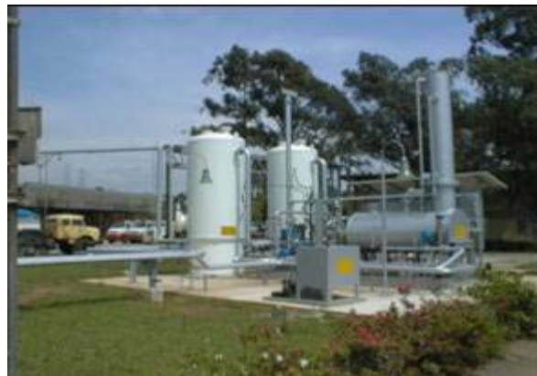
URV – Unidad de recuperación de vapores por condensación y de enrutamiento de tanque.
